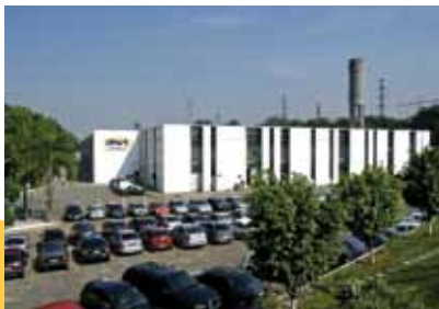
Fábrica em São Bernardo do Campo - SP: 70.000 m 2 .
